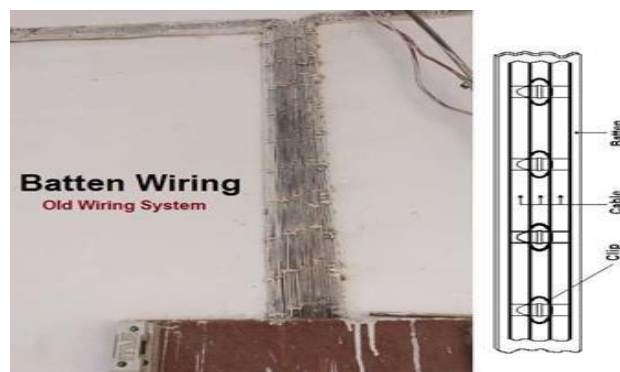
Fig.2.6. Batten Wiring.
